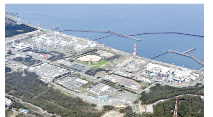
日本东京电力公司4月15日宣布,日本原子能规制委员会已批准其重启新潟县柏崎刈羽核电站7号机组,当天下午,该机组反应堆开始装填核燃料。福岛第一核电站2011年发生严重核泄漏事故后,东电停运其所有核电站,装填核燃料是东电为重启核电站所做预备工作,重启时间尚不清楚。 这是2021年4月在日本新潟县拍摄的柏崎刈羽核电站。
