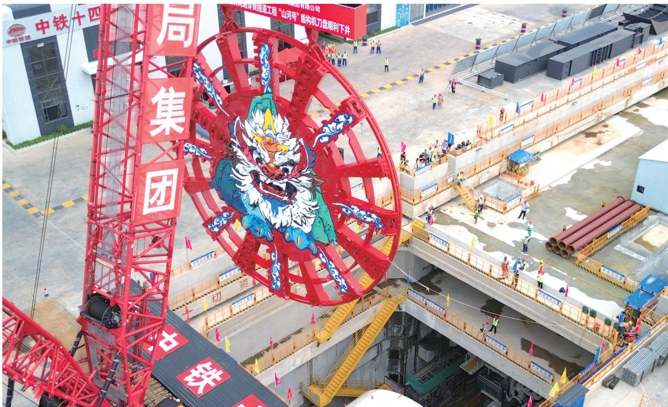
7月24日,“山河号”盾构机刀盘被履带式起重机从地面吊运至济南市黄岗路穿黄隧道盾构始发井(无人照机片)。当日,由中铁十四局集团承建的济南市黄岗路穿黄隧道“山河号”盾构机刀盘顺利吊装下井,为黄岗路穿黄隧道盾构始发井穿黄奠定基础。黄岗路穿黄隧道是济南市跨黄河通道总体布局中的重要一环,工程建成后助力济南主城区与新旧动能转换起步区互联互通,促进济南跨黄河发展。
