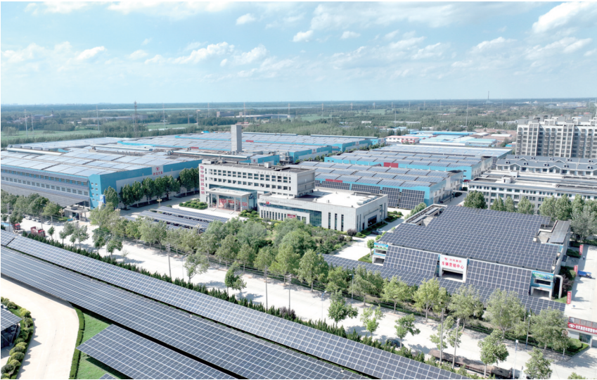
时风集团“顶棚”太阳能光伏板项目
