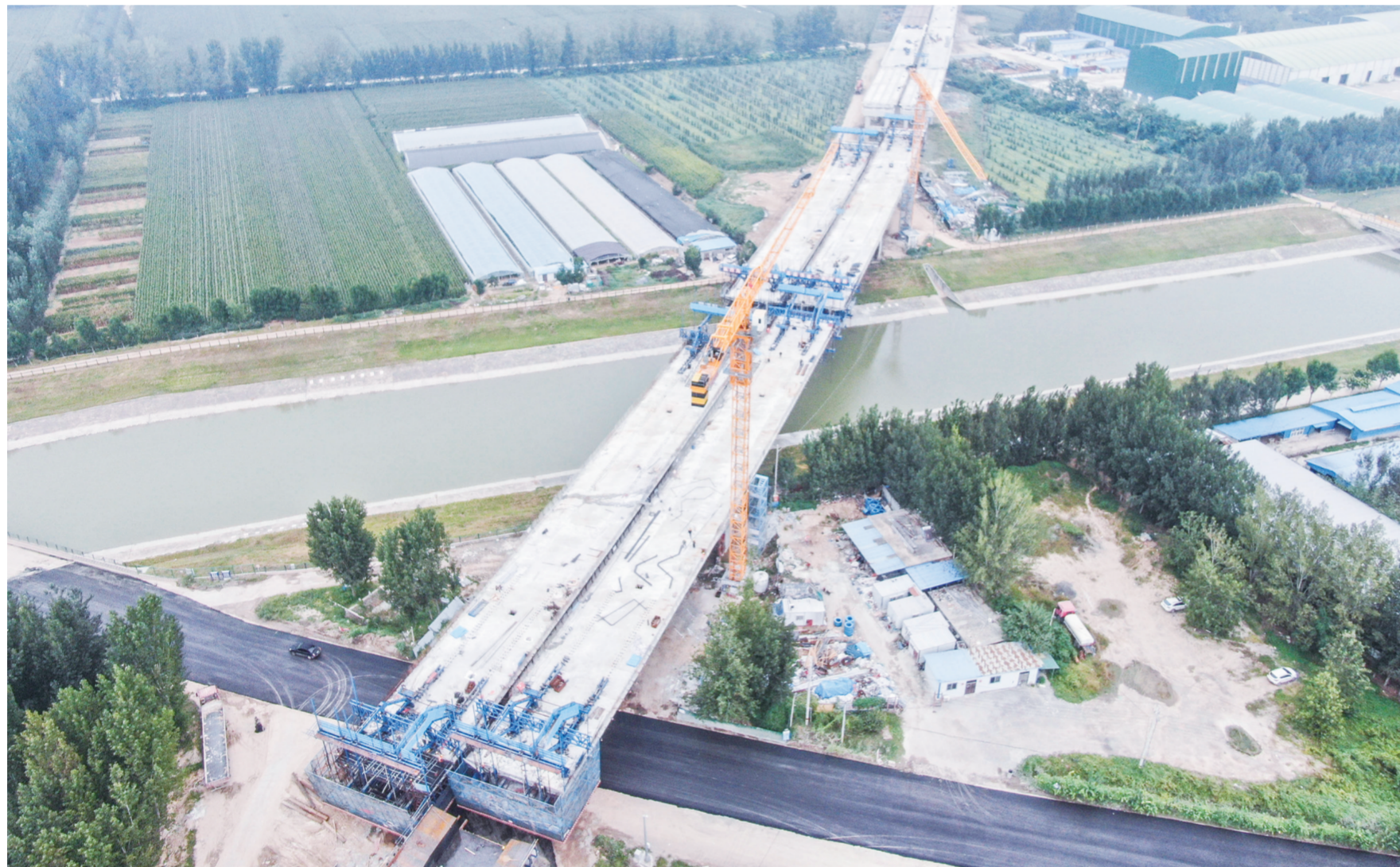
9月23日,东阳高速TJ2标段项目现场,工作人员正在施工。作为山东省“十四五”综合交通运输发展规划的重点项目,东阳高速建成后,将进一步补齐聊城市交通建设短板,完善高速公路网络格局,对加快区域经济高质量发展具有重要意义。
