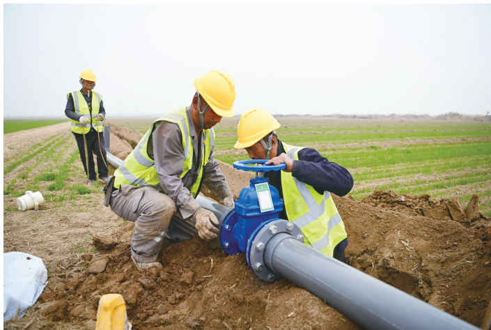
11月15日,在东昌府区梁水镇郑庄村高标准农田,工人在铺设安装灌溉管道。初冬时节,我市各地加紧推进农田水利、设施大棚、生产路等基础设施建设,提升农业生产条件,为来年粮食增产、农民增收打好基础。
