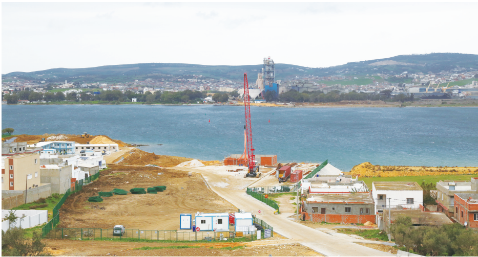
这是12月20日在突尼斯比塞大大桥项目工地拍摄的比塞大大桥项目工地。 ■ 新华社记者 黄灵 摄
