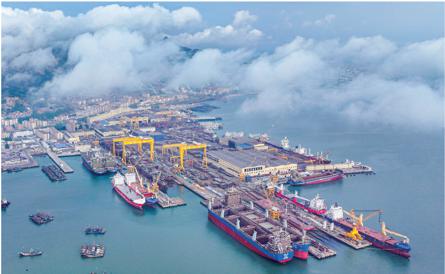
5月8日拍摄的山东省荣成市石岛管理区修造船产业基地船坞(无人机照片)。 近年来，山东省荣成市抢抓“向海兴运 走向深蓝”战略机遇，大力发展修造船产业，加大技术创新力度，优化产业链合作，增强市场竞争能力，在超大型集装箱船、远洋捕捞船、大型液化天然气船等维修和制造领域取得明显进展，成为我国重要的修造船产业基地之一。 ■ 新华社发 李信君 摄
