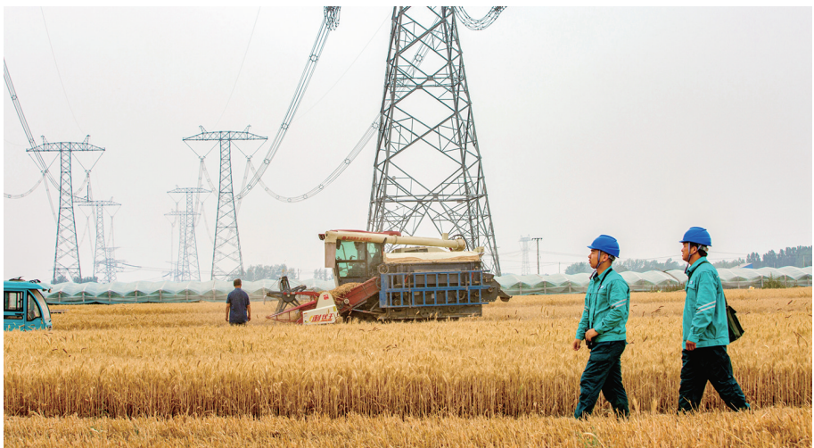
工作人员在巡视穿越麦田的电力线路。■ 于刘庆 高翔
