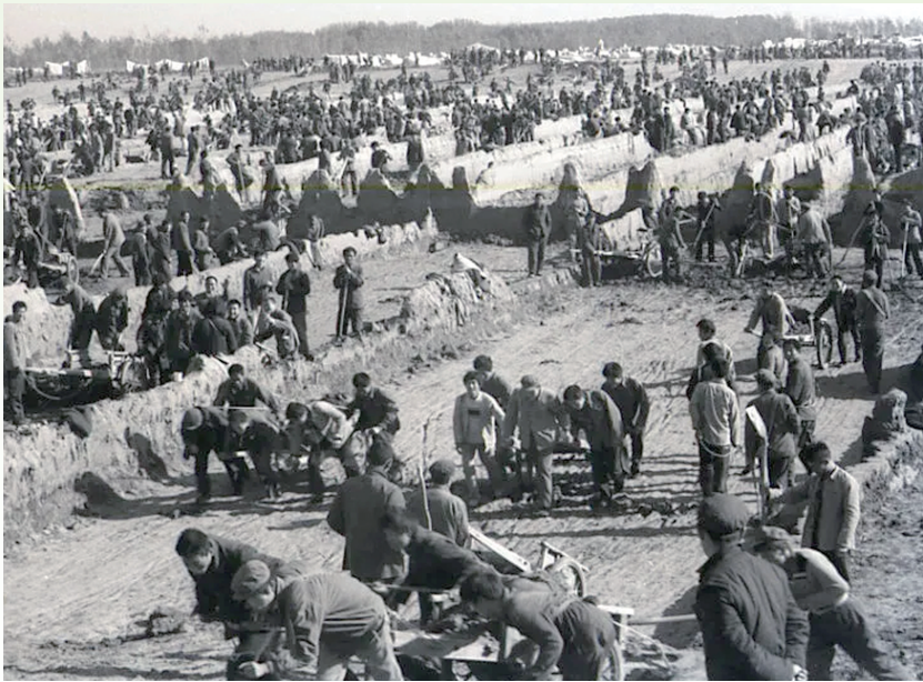
1981年11月,引黄济津工程沉沙池清淤(资料图)
