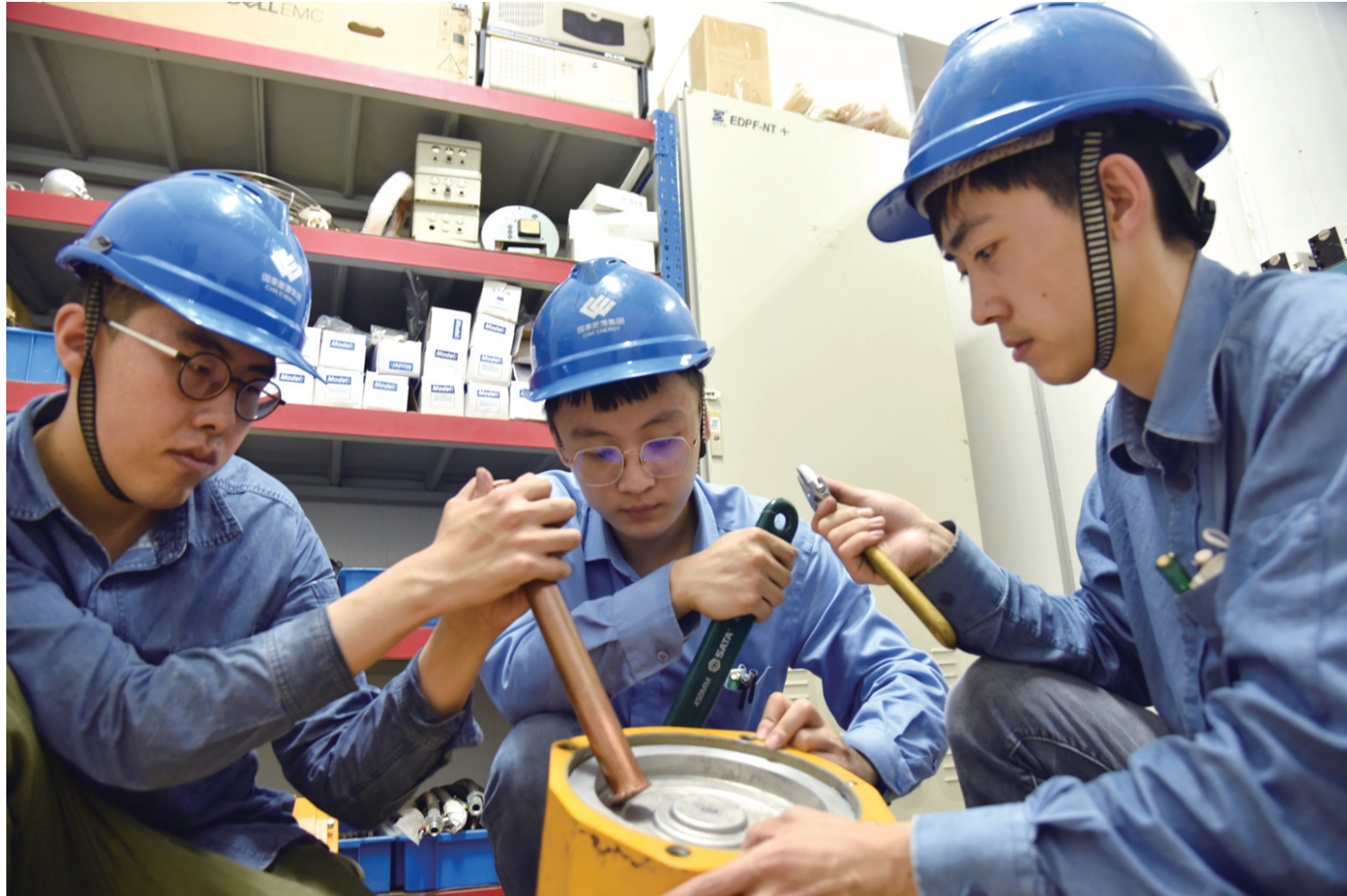
7月16日,国能聊城发电公司炉控班人员在修复磨煤机热风门。
