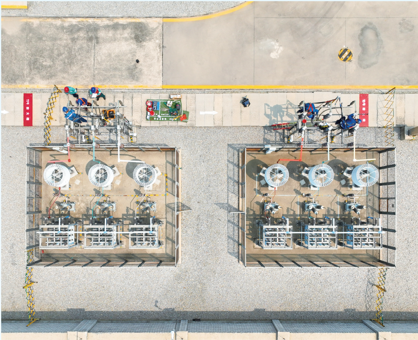
高温下的电容器检修现场
