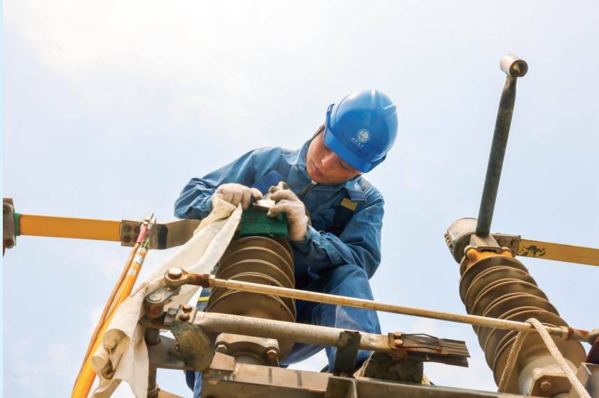
清洁变压器刀闸,涂抹防污闪涂料
