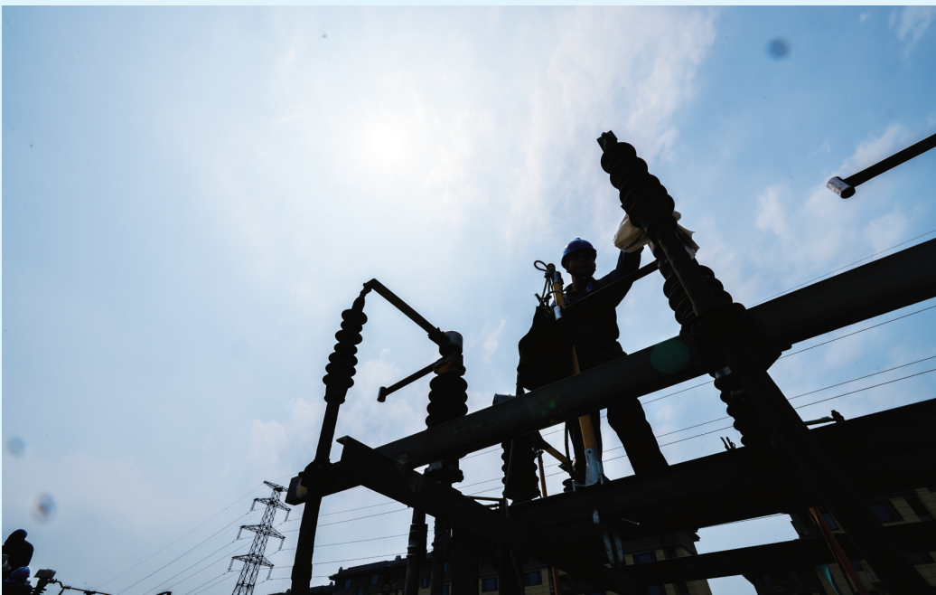
在烈日下检查变压器刀闸设备情况
