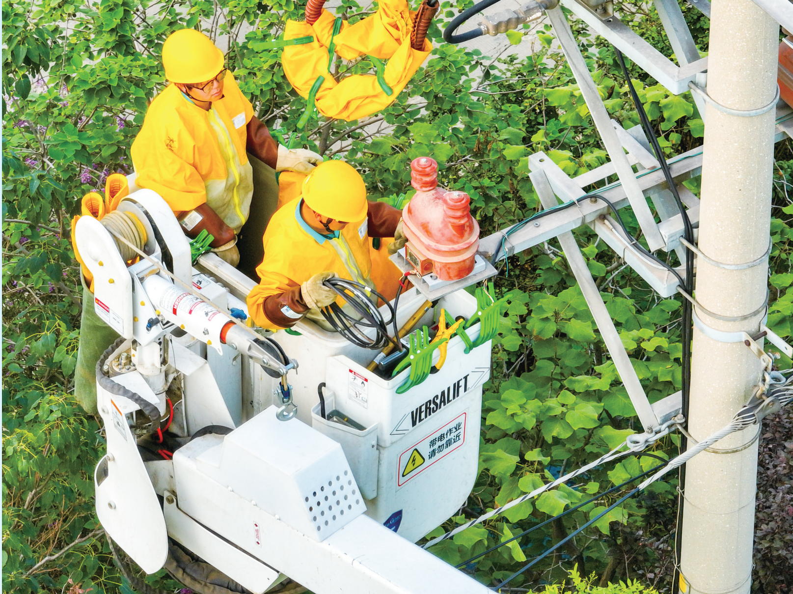
冒高温开展带电作业
