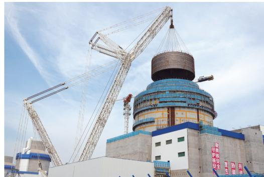
这是8月4日拍摄的山东海阳核电3号机组核岛CB20模块吊装现场。当日,国家电投山东海阳核电站3号机组核岛CB20模块顺利吊装就位,标志着该机组大型模块全部吊装完成,开始进入设备安装调试阶段。据了解,建设的海阳核电3、4号机组是国家“十四五”规划重点项目,计划2027年全面投运。新华社发 唐克 摄
