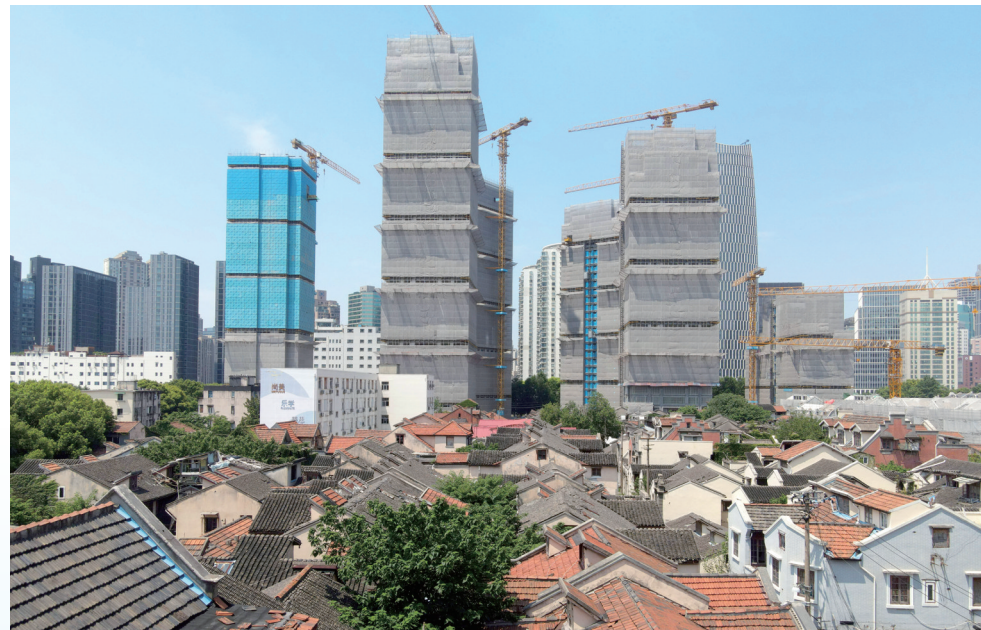
2025年8月5日 上海黄浦区508-514街坊地块旧城区改造一期项目建设中的楼房(7月15日摄,无人机照)。
