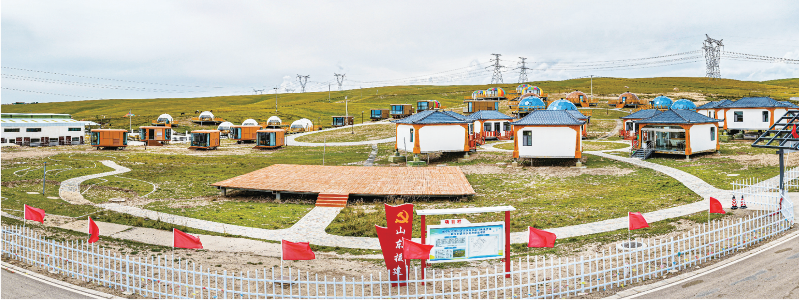
已投入运营的刚察县沙柳河镇果藏贡麻村帐篷营地二期乡村振兴示范点项目
