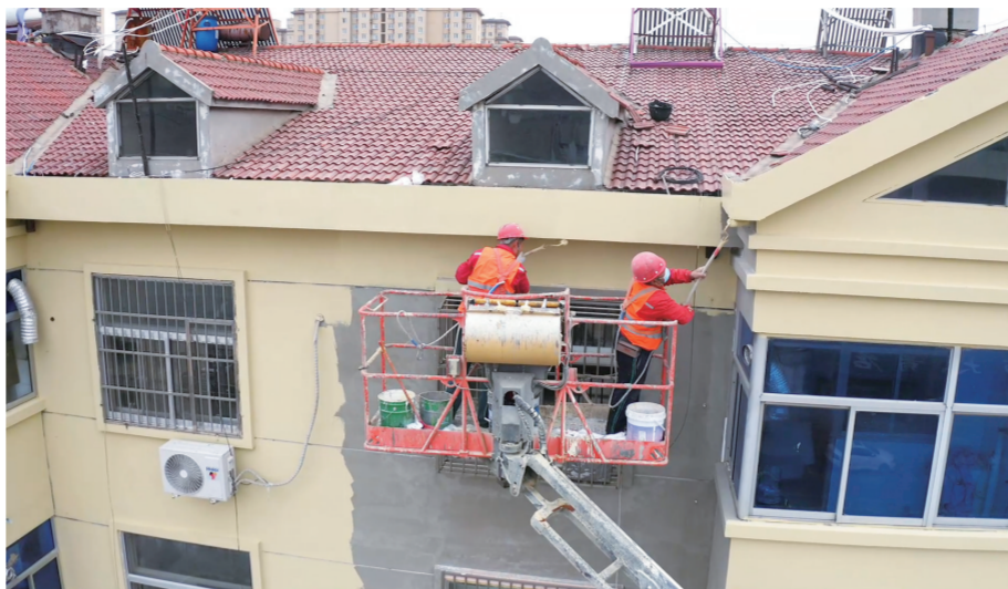
工人正在粉刷外墙
