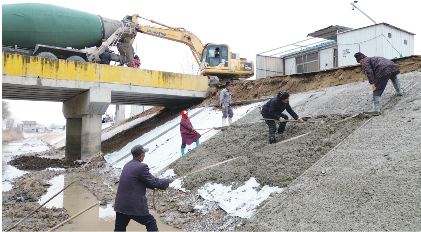
1月17日,阳谷县十五里园镇,施工队在对沟渠岸坡进行水泥加固作业。
