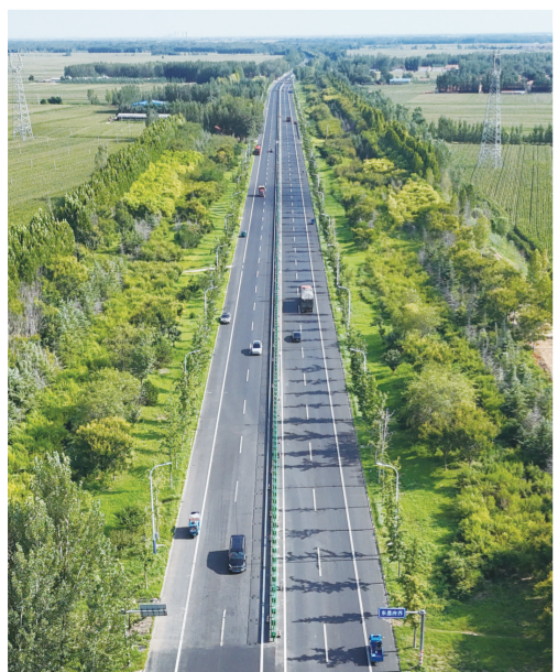
S246临鄒线临清东昌府界至东昌府梁水镇段路面改造工程
