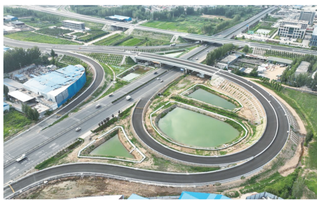
临沂至滕州高速公路施工三标段
