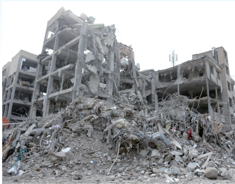
这是3月12日在伊朗德黑兰东部一处居民区拍摄的被毁房屋。到处是新壁残垣,有的居民楼只剩“骨架空壳”,有的居民楼完全坍塌,化作堆叠的混凝土碎块……在伊朗首都德黑兰东部一处居民区,置身其中仿佛走进科幻电影中的“末日街区”。
