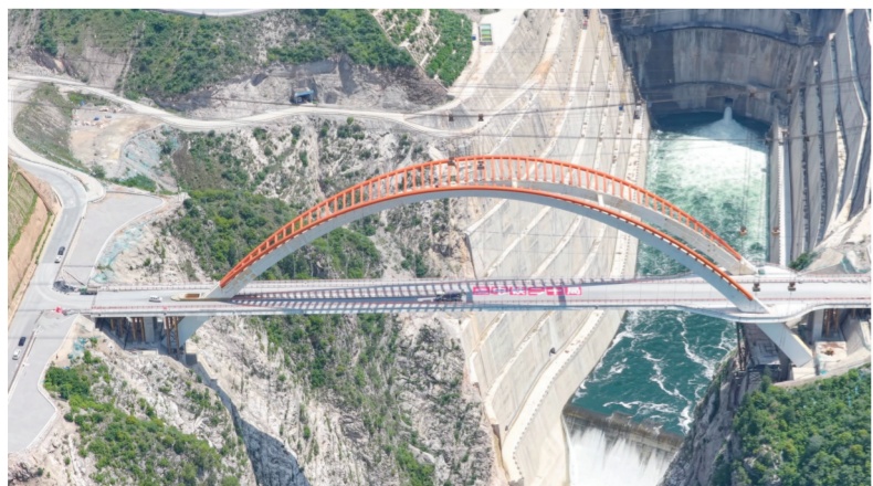
5月21日拍摄的陕西东庄水利枢纽泾河大桥(无人照照片)。5月21日,由中铁二十局承建的陕西东庄水利枢纽泾河大桥开工。泾河大桥全长284米,是国内首例U型钢箱拱桥。东庄水利枢纽是国家重大水利工程,泾河大桥的建成不仅能保障东庄水利枢纽的建设,也能改善区域交通条件。 新华社发 王凯强 摄
