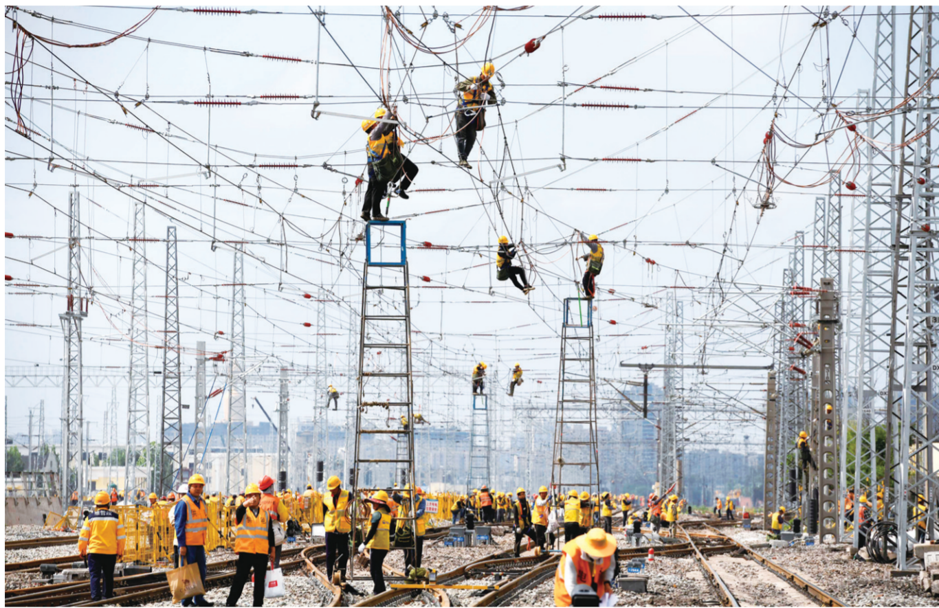
5月27日,在山东兖州北站扩能改造工程施工现场,中铁十局的工作人员在进行接触网改造作业。
