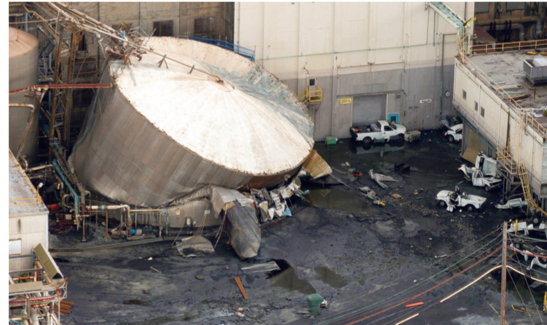
这是5月26日在美国华盛顿州朗维尔市拍摄的发生内爆事故的化学储罐（无人机照片）。美国华盛顿州当地官员5月27日说，26日朗维尔市日资企业化学储罐内爆事故的死亡人数已升至两人，另外，失踪的9人已被推定死亡。新华社/路透
