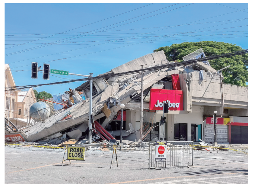
这是6月8日地震发生后在菲律宾桑托斯将军城拍摄的损毁的建筑。菲律宾减灾部门6月8日通报说,当天早上菲南部发生的7.8级地震已造成15人死亡、134人受伤。 ■ 新华社发
