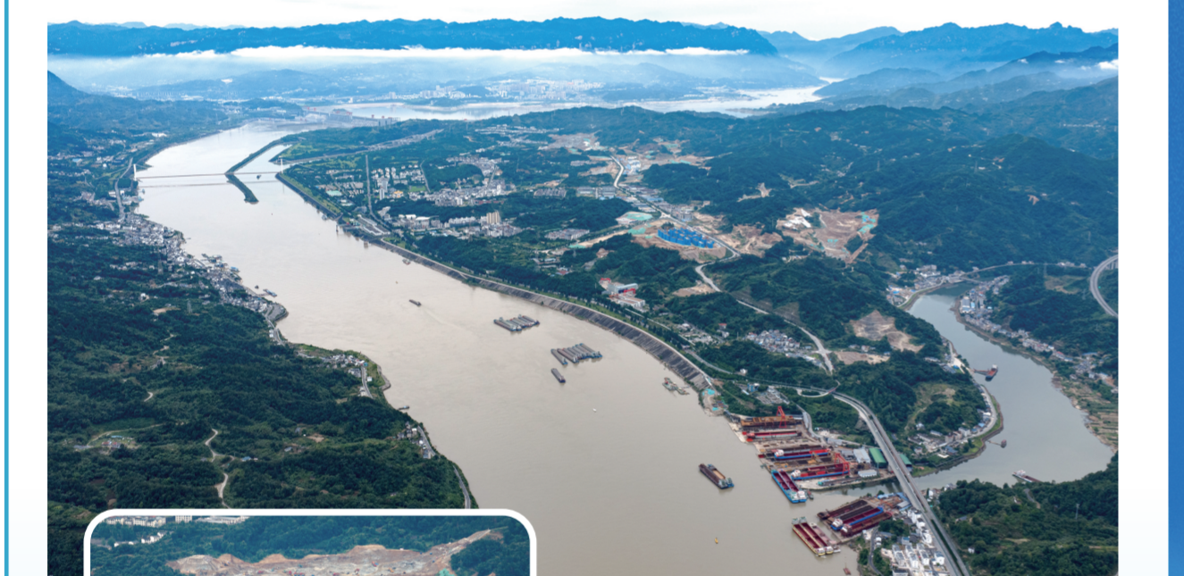
6月8日拍摄的三峡水运新通道工程三峡枢纽新通道施工现场。 总投资约772.08亿元的三峡水运新通道工程,由两部分组成。其中,三峡枢纽新通道位于已建三峡船闸北侧,规划新建双线连续五级船闸,线路长约6680米,工期为112个月(含12个月工程筹建期)。
