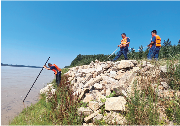
7月23日，东阿黄河大桥管理段一线职工身穿救生衣，在险工坝岸开展根石探测作业。近日，东阿黄河水务局强化工程巡查值守，抓实隐患排查整治，全力确保防汛关键期水利工程安全平稳运行。
