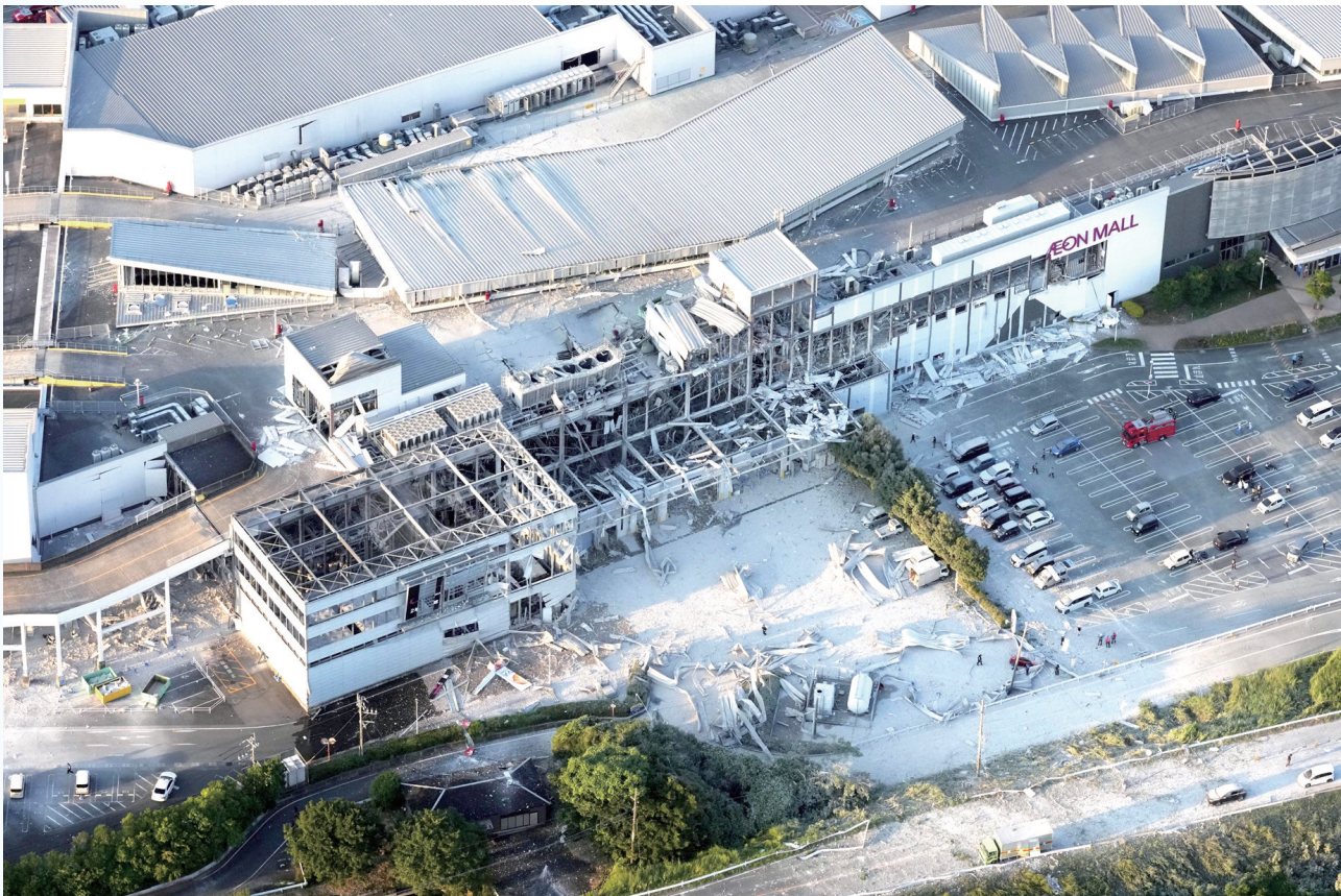
日本熊本县警方:地震波及的商场可能有大量人员死亡
