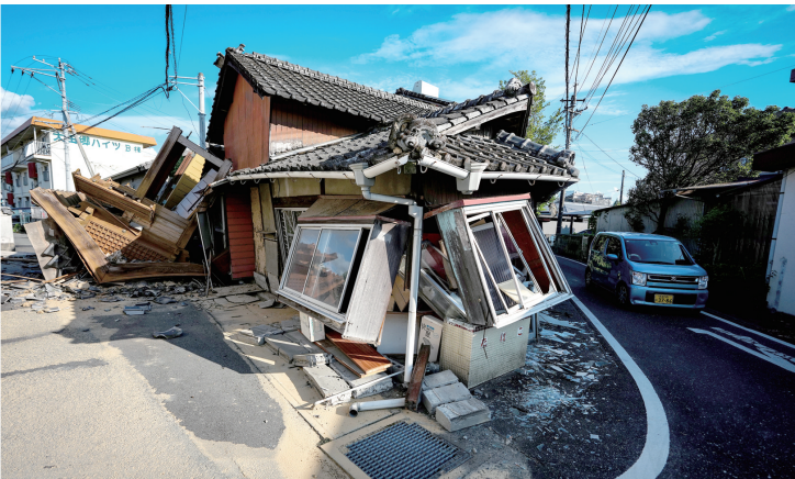
这是7月29日在日本熊本县拍摄的一处损毁的房屋。 ■ 新华社记者 贾浩成 摄
