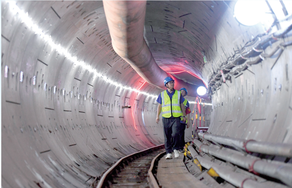
工作人员在天津市滨海新区雨污分流改造工程项目雨水主管隧道内检查盾构管片。 ■ 新华社记者 赵子硕 摄
