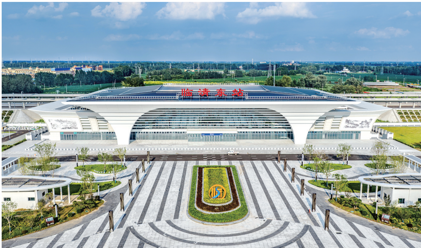
9月12日，京港高铁雄商段临清东站外景。该站站房建筑面积9998平方米，建筑中部设双侧横向延展立柱，塑造出建筑腾飞态势；柱间自然形成拱形结构，契合“运河钞馆·临清门户”设计理念；超大挑檐及弧形立柱采用一体化铝板定制安装，缝隙顺直规整，线条简洁大气。
