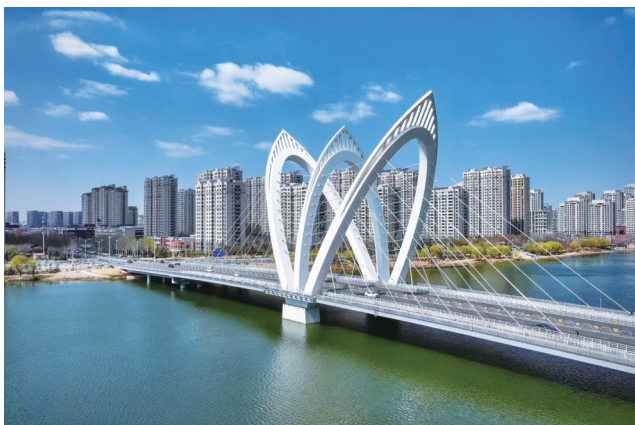
兴华路跨徒骇河大桥
