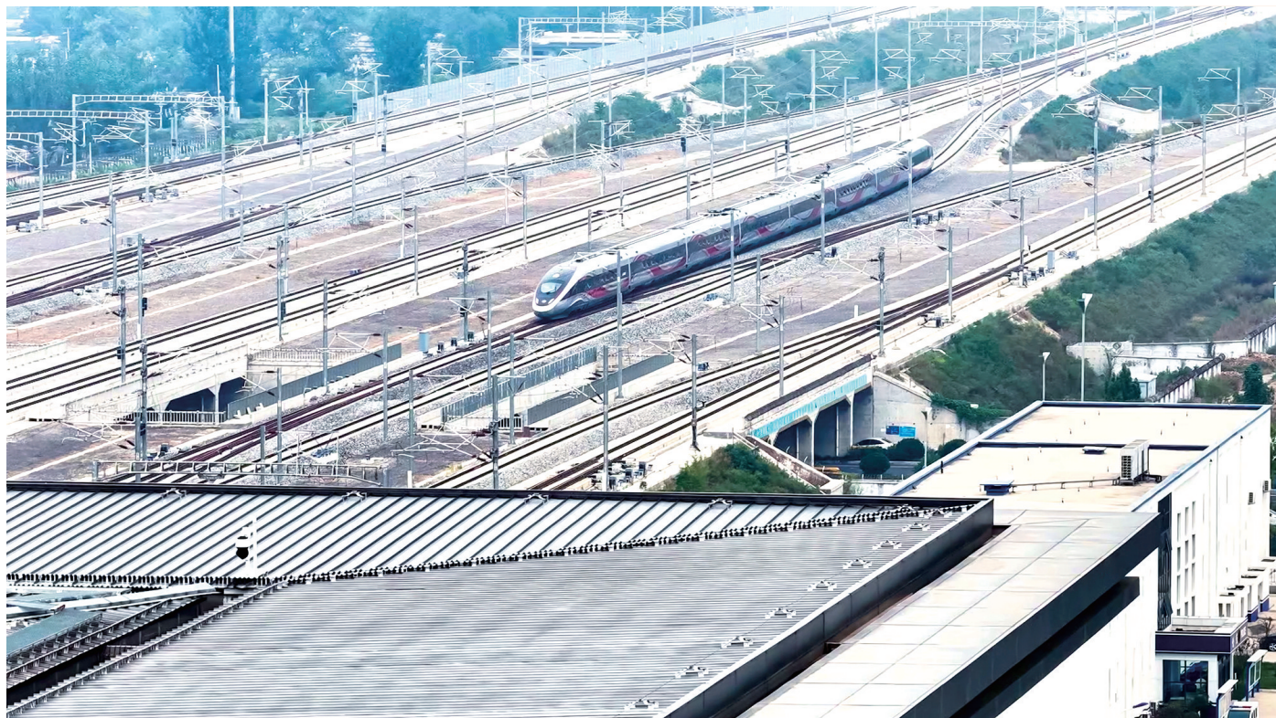
9月28日，京港高铁雄商段正式开通运营。上午10时39分，从北京西站驶出的G3935次高铁列车平稳驶入聊城西站。 ■ 郭德鹏 郭彦哲 张晓
