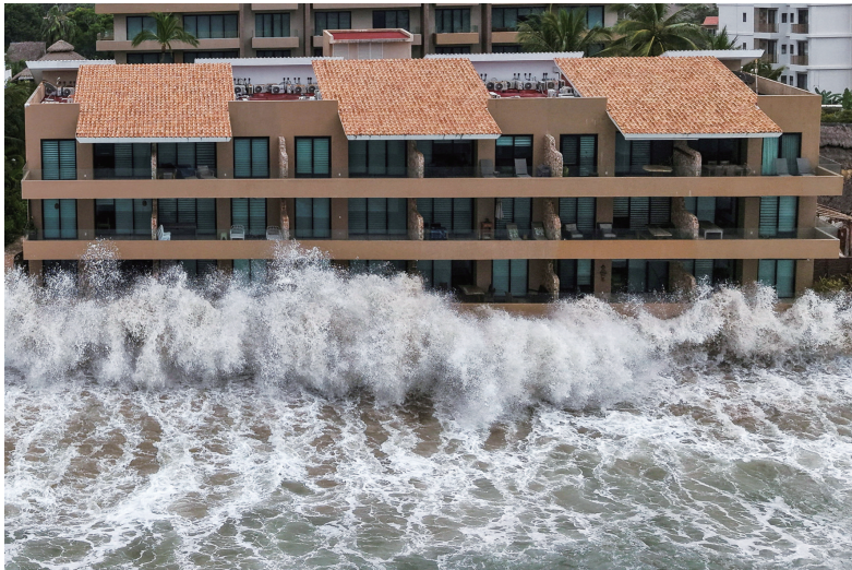
10 月 12 日,在墨西哥纳亚里特州,海浪拍击岸边的房屋(无人机照片)。据墨西哥政府部门 10 月 12 日消息,飓风“西蒙”和热带风暴“雷切尔”近日袭击墨西哥太平洋沿岸多地,引发洪水、山体滑坡等灾害,已造成至少 5 人死亡、5 人失踪。 ■ 新华社/路透
