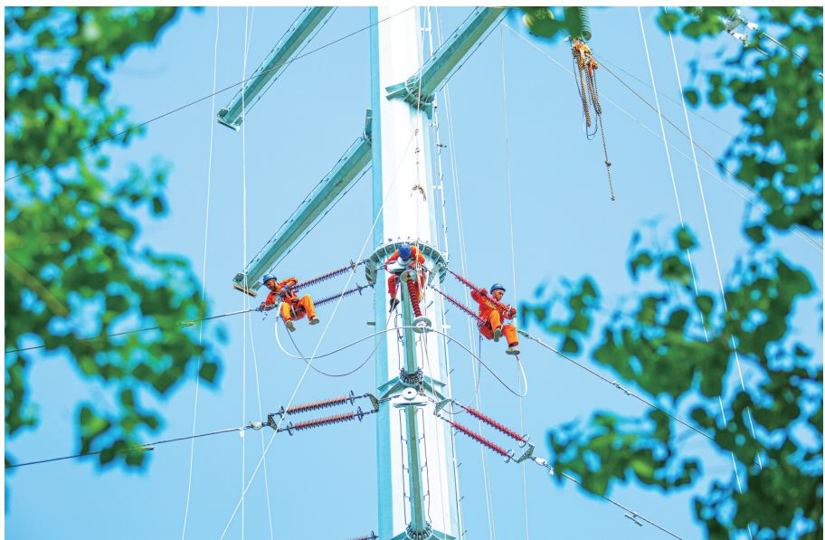
2023年8月9日,国网聊城供电公司工作人员开展京港高铁雄商段电力迁改施工作业
