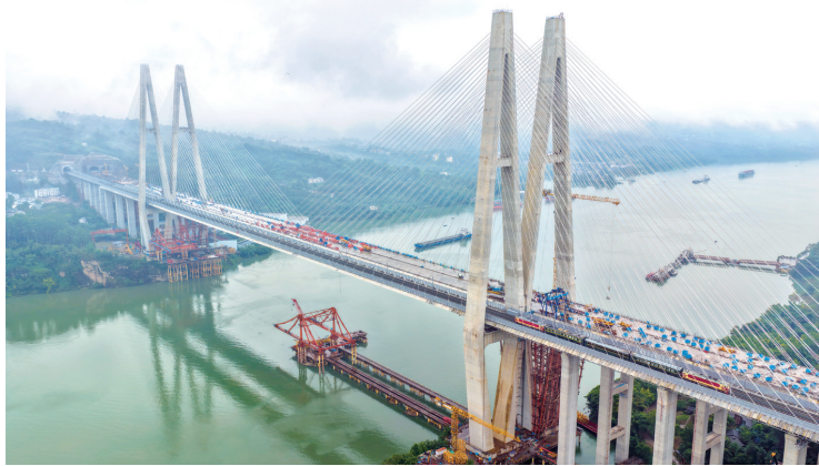
10 月 20 日,检测车行驶在渝万高铁线路上(无人机照片)。
